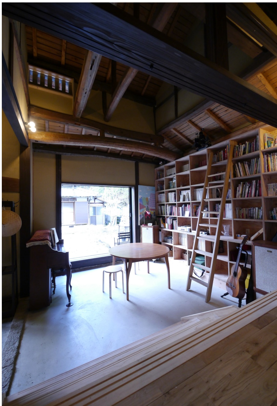
昔は土間だったところを元どおりに復旧。壁引き込みの全面開口サッシをいれて外と繋げる
