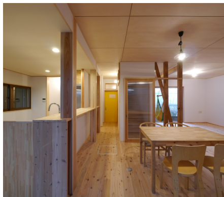
1階を大きな一室空間にした築30年のリノベ。冬、階段から2階床の冷気を防ぐために建具取り付け。正面奥の黄色い建具は既存建具をペンキ仕上げ
